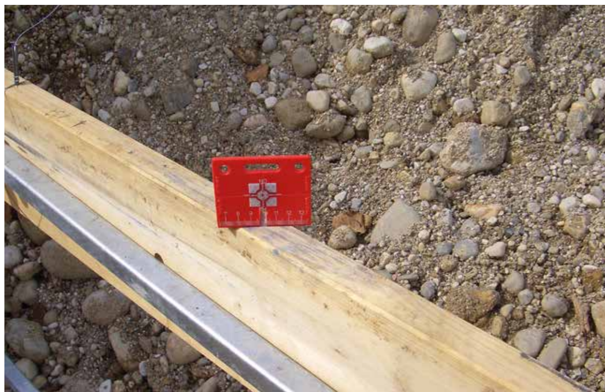
RS95 – Travaux de piquetage sur le gabarit d'implantation (sur le banquetage).
