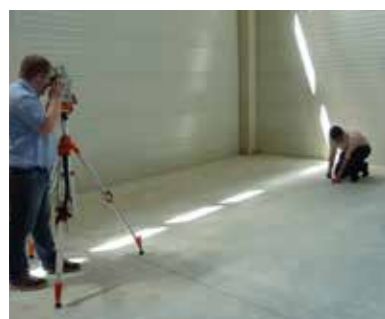
RS95 – Travaux de piquetage sur le gabarit d'implantation (sur le banquetage).
