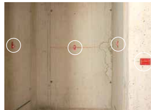
RSAK130 et RS21 : points de reprise parfaits pour le trait de niveau et les axes dans la zone d'ascenseur
